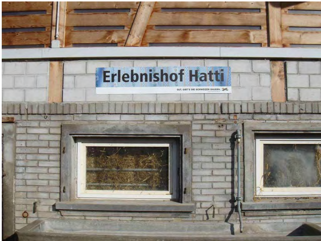
Die Tafel auf vorhandene Strukturen ausrichten
